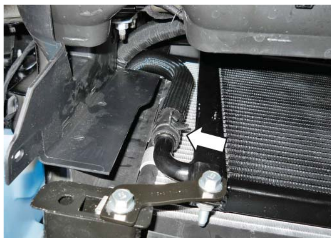
Шланг отвода от насоса межколлекторного охлаждения (1315-6K236)
