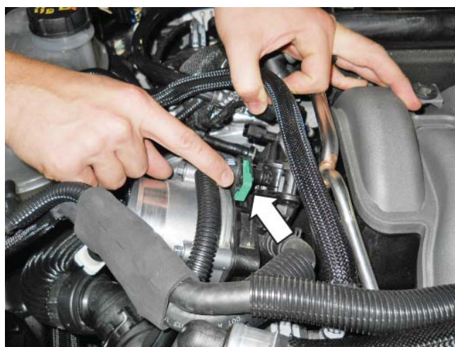
Быстросъемное соединение трубки ЕЕСРV с зеленым замком
