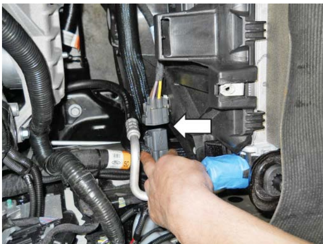
Электрический разъём вентилятора
