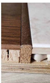
Корковий компенсатор на стиках підлоги передпокій/спальня, передпокій/ванна кімната, кухня.
