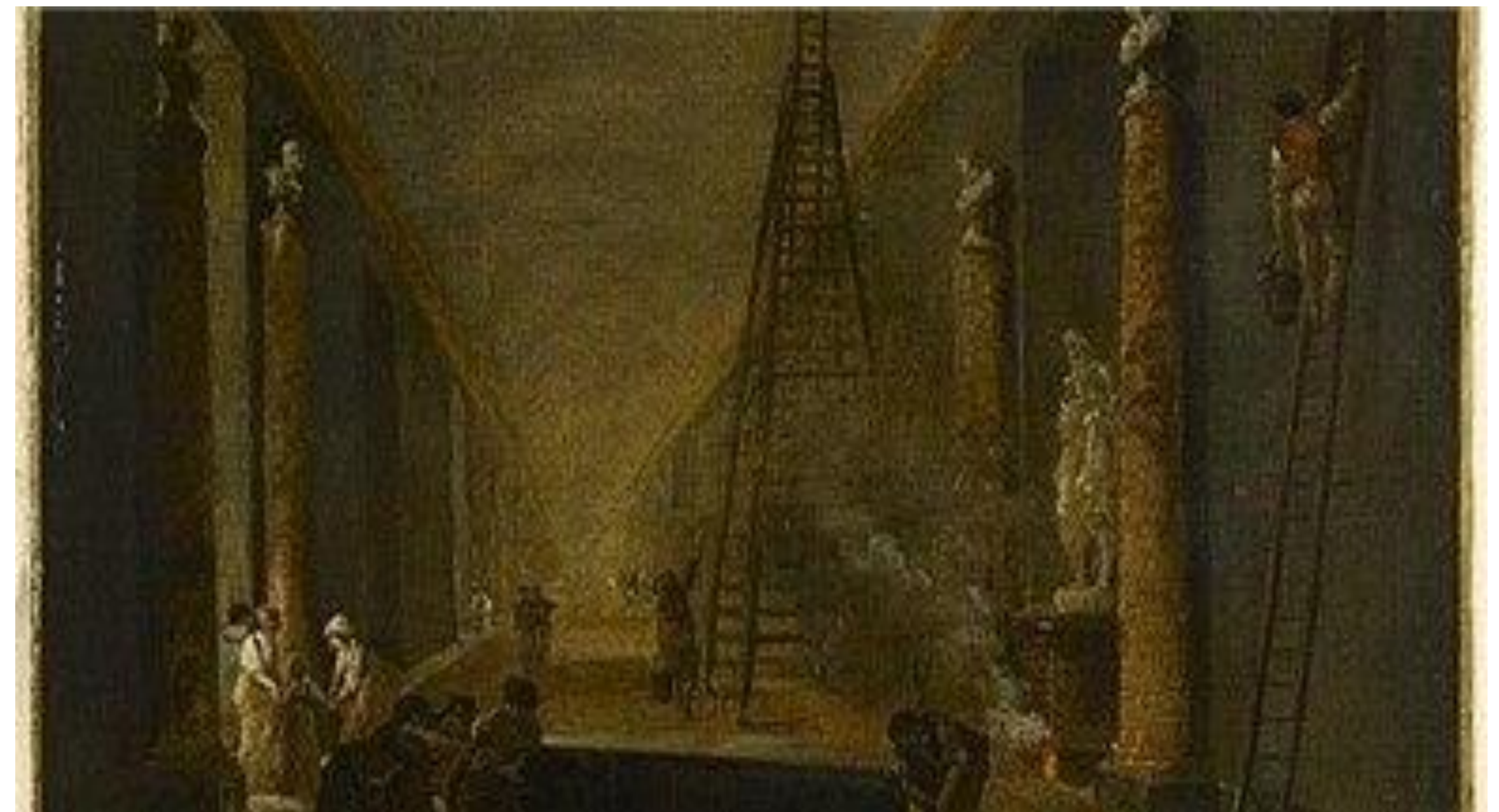
Большая галерея Лувра во время реставрации. Работа Юбера Робера
