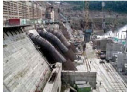
В 2008 г. предполагается довести до проектной отметки высоту плотины и осуществить замену временных рабочих колес первых двух гидроагрегатов на постоянные, благодаря чему их суммарная мощность увеличится на 300 МВт. Среднегодовая выработка Бурейской ГЭС после выхода на проектную мощность в 2000 МВт составит 7,1 млрд. кВтч, что соответствует пятой части выработки всей дальневосточной энергосистемы.
